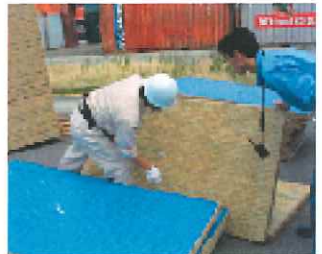
タタミ床 Tatami Toko 韓国産。この上にイグサマットを張って、タタミとして完成させます。
